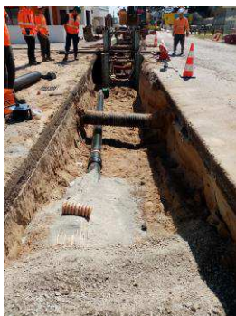
Travaux réseaux eaux usées, Fort Bloqué à Ploemeur
