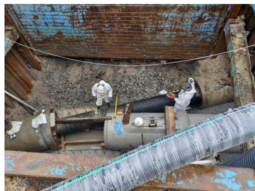
Dévoisement de réseau rue du sous-marin Vénus à Lorient.
