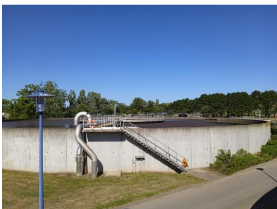
Station d'épuration de Lorient KEROLAY
