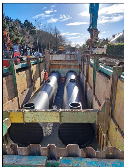
Travaux sur Poste de relevage PR Central à Larmor-Plage
